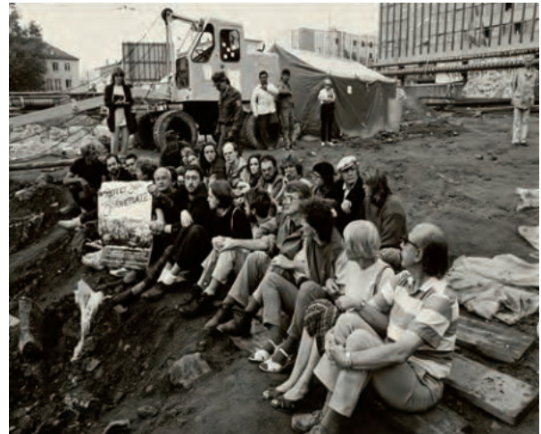
Demonstrant*innen besetzen die Baustelle der Stadtwerke, um die Überreste der Judengasse zu sichern.
