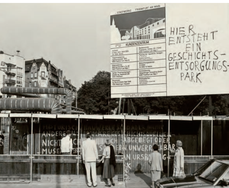
Baustellenschild der Stadtwerke am Börneplatz mit Graffiti als Kritik an dem Umgang mit der jüdischen Frankfurter Geschichte
